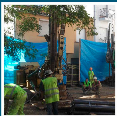
Mise en place de micropieux
