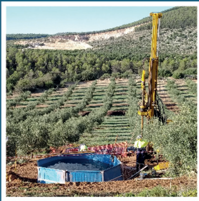
Perforaciones con sistema Wire-Line
