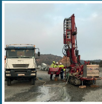
Perforación con sistema Sonic Drilling
